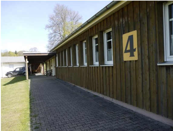
Abb. 10: Die Vertikale Holzverkleidung schließt ab und bietet daher keine Hohlräume.
