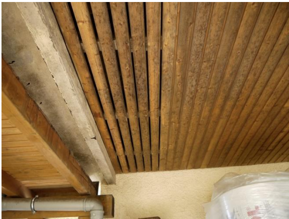
Abb. 13: Offener Lattenboden am Dachboden des Haupthauses, welcher der Belüftung dient. An diesem Dachboden fanden noch Dämmarbeiten statt.
